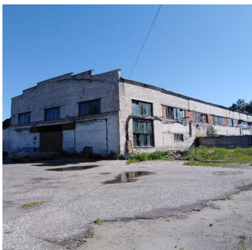
9. Встроенное помещение цеха по изготовлению запасных частей к мотоциклу «Восход», кадастровый номер 33:25:000000:391
